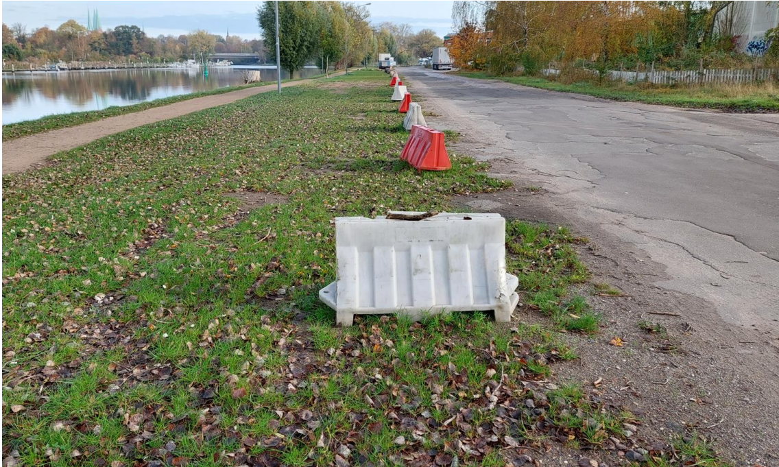
Abb. 3: Blick nach Nordosten - Höhe Geniner Ufer 8-9 (Bauabschnitt 2). Zwischen dem Wanderweg im linken Bildrand und der Straße befindet sich ein Grünstreifen. Diese Freifläche ist auch auf älteren Luftbildern zu erkennen.
