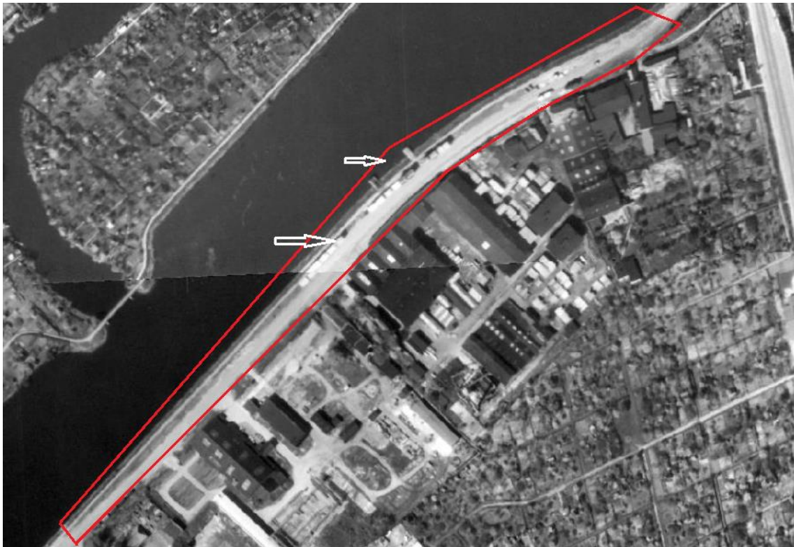
Abb. 3: Luftbild von 1961. Die Untersuchungsfläche ist rot markiert. Mit weißen Pfeilen sind zwei Anlegestellen (wie auch schon auf dem Luftbild von 1953) und ein Lagerplatz - Höhe Hobelwerk - markiert (Quelle: uBB Lübeck).
