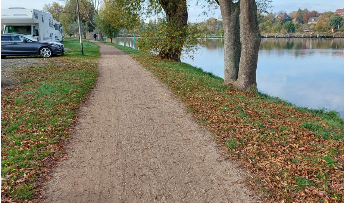
Abb. 9: Blick nach Südwesten auf der Höhe Geniner Ufer 3 entlang des Wanderweges. Der Wanderweg wird bei den zukünftigen Baumaßnahmen aufgenommen und neugestaltet.
